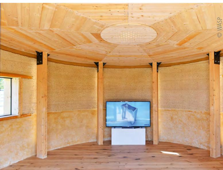
Abb. 3: Erster Prototyp gedruckter Lehmartitektur 2012: Der Einraum – Gaia genannt – hat gerade Wände und ist innen bis Brüstungshöhe mit Lehm verputzt
