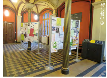
Abb. 5: Änderungsbedarf in einem notwendigen Treppenraum
