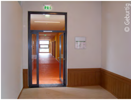
Abb. 3: Hölzerne Lambris in einem notwendigen Flur
