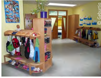
Abb. 4: Für die Rettung und als Feuerwehrrangriffsweg geeigneter Spielflur in einer Kita
