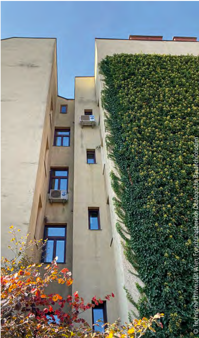
Abb. 2: Die unbegrünte Referenzwand (links) und die mit Efeu begrünte Fassade (rechts) am Standort Kopalgasse 7, Wien
