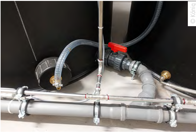
Abb. 2: In die Behälter der Wirbelbettreaktoren wird von unten Luft zugeführt, um die biologische Wasserreinigung zu beleben. Dabei sich absetzende partikuläre Substanzen werden mechanisch ausgeschleust. Oben an den Behältern erfolgt der Druckausgleich mit Abluftrohren.
