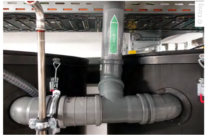
Abb. 2: In die Behälter der Wirbelbettreaktoren wird von unten Luft zugeführt, um die biologische Wasserreinigung zu beleben. Dabei sich absetzende partikuläre Substanzen werden mechanisch ausgeschleust. Oben an den Behältern erfolgt der Druckausgleich mit Abluftrohren.
