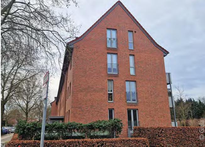
Abb. 2: Instandgesetztes Mehrfamilienwohngebäude aus den 1950er-Jahren. Die heutigen Mindestanforderungen an den Schallschutz lassen sich nur mit sehr hohem Aufwand erreichen, da das alte Tragwerk eine geringe Direktschalldämmung aufweist. Mangelnder Schallschutz ist ein Hauptkriterium für Abriss und Neubau.
