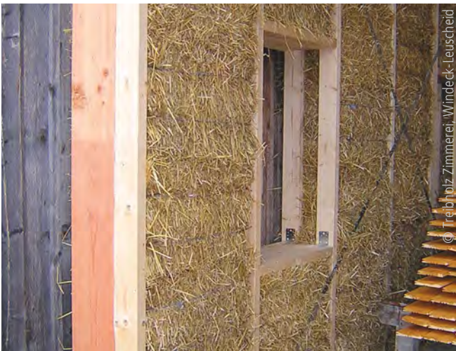
Abb. 2 und 3: Vorfertigung kompletter Wandelemente
