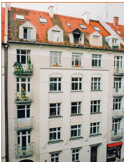
Abb. 7: Die brandbetroffene Wohnung lag in der unteren Dachgeschossebene.
