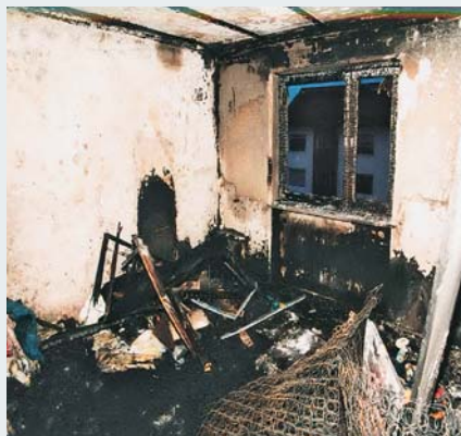
Abb. 4: In diesem Kinderzimmer wurde der vierjährige Sohn vom Brand überrascht. Da kein Rauchwarnmelder installiert war, hatte das Kind keine Chance und starb (vermutlich, ohne vorher aufzuwachen). Der Junge wurde erst bei den Löscharbeiten von der Feuerwehr gefunden.
