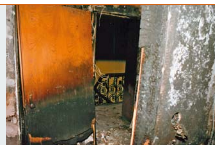
Abb. 9: Tür vom Wohnungsflur zum notwendigen Treppenraum: Da in der Wohnung keine Rauchwarnmelder montiert waren, bemerkten die Bewohner das Feuer erst, als es bereits zu spät war. Es hatte sich in den Wohnungsflur ausgebreitet. Damit war die Tür zum notwendigen Treppenraum nicht mehr zugänglich.
