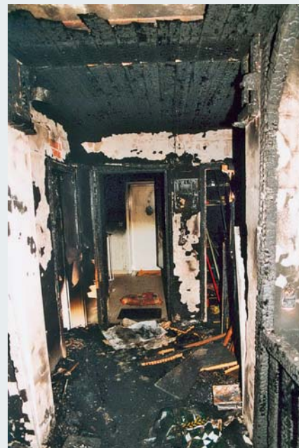
Abb. 5: Der Wohnungsflur mit Blick auf die Treppe. Der baulich gesicherte erste Rettungsweg beginnt erst an der Wohnungsangangstür zum notwendigen Treppenraum. Als die Mutter schließlich wach wurde, hatten sich Feuer und Rauch bereits so auf den Flur ausgebreitet, dass die Wohnungsangangstür zum rettenden ersten Rettungsweg nicht mehr erreichbar war. Auch das Telefon zur Alarmierung der Feuerwehr war nicht mehr zugänglich.
