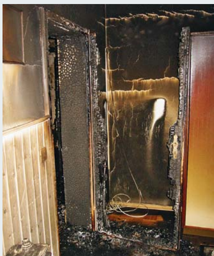
Abb. 11: Die Türen zu den Wohnräumen hielten dem Feuer im Flur nicht lange stand. Für die Bewohner blieb daher nur noch die Flucht auf das Dach. In anderen Geschossen wäre wohl nur der Tod als Folge des Sprungs aus dem Fenster oder durch Rauchvergiftung eingetreten.
