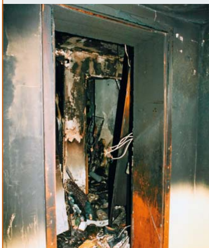
Abb. 10: Blick vom notwendigen Treppenraum in den Wohnungsflur
