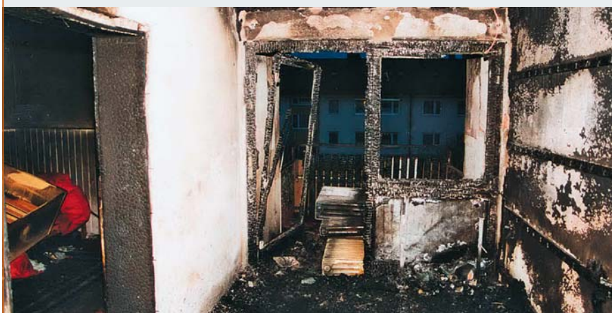
Abb. 6: Links die Tür zum Schlafzimmer und vorn der Balkon, von dem die Mutter in den Tod sprang. Die Mutter konnte auch nicht im Schlafzimmer auf die Feuerwehr warten, da die Türe vom Flur zum Schlafzimmer durchbrannte.
