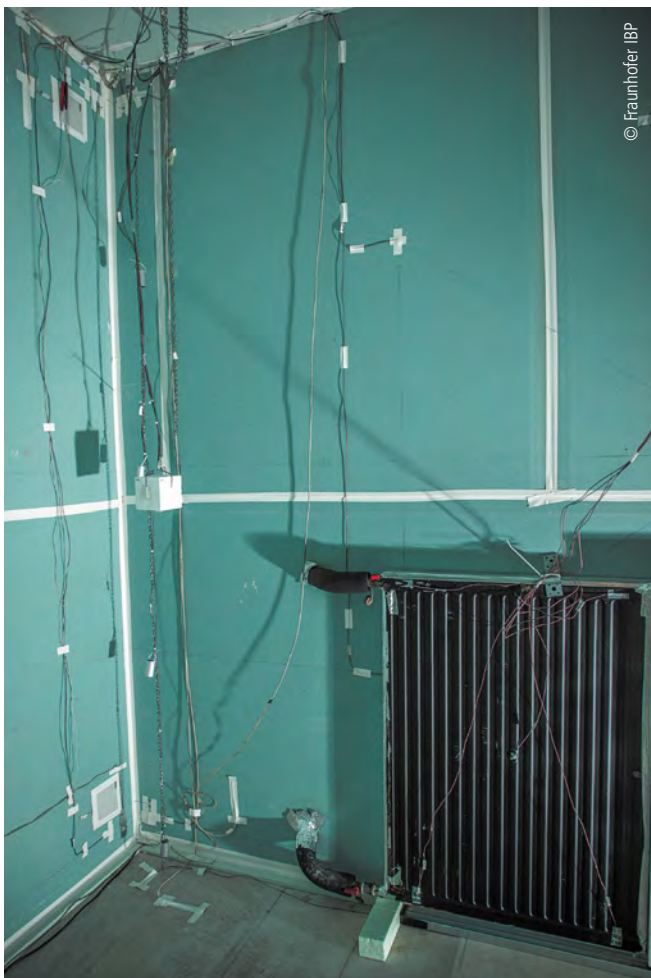
Abb. 2: Blick auf die Ecke des Testraums mit Radiator
