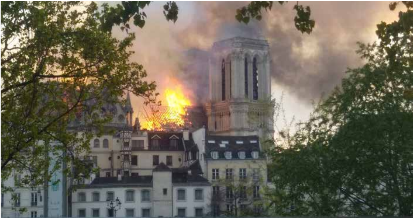
Bild 1: Holzkonstruktionen können sich im Brandfall durchaus ebenbürtig zu anderen Bauweisen erweisen. (Quelle: Remi Mathis auf Wikimedia)
